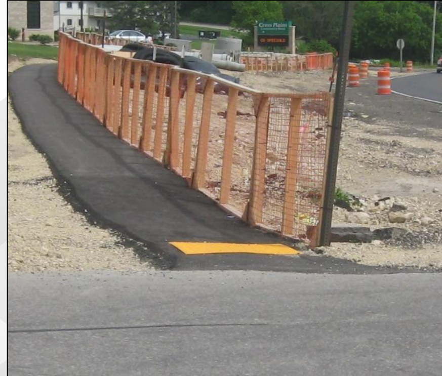
Improve Edge - backfill
